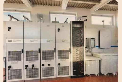
Sistema di conversione e gestione della potenza (FRIEM) e Sistema di accumulo (FAAM)
